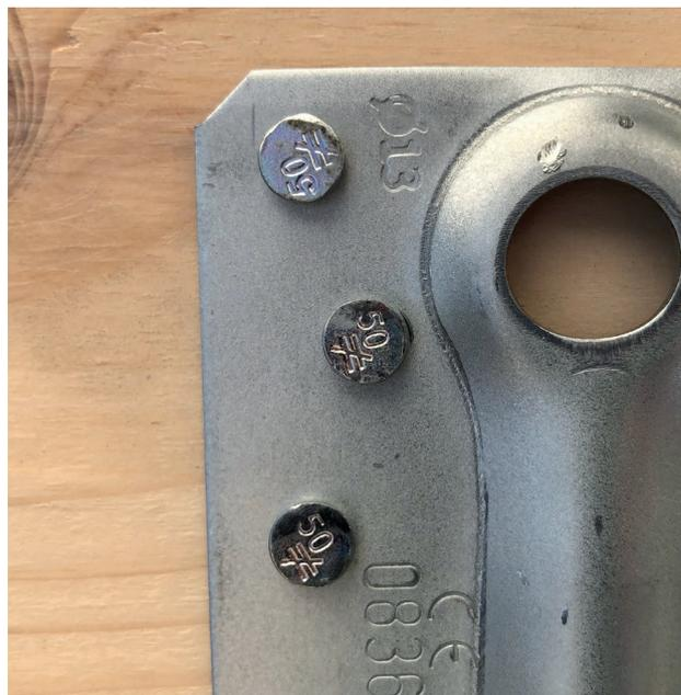
A marcação no conector, além da marcação nas cabeças dos pregos, permite uma verificação fácil após a instalação.
