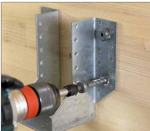
Suporte **SAE** instalado com **SSH**
