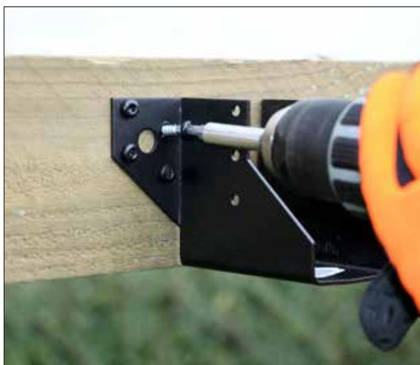
Suporte **SAE-PB** preto instalado com parafusos **CSA-PB**
