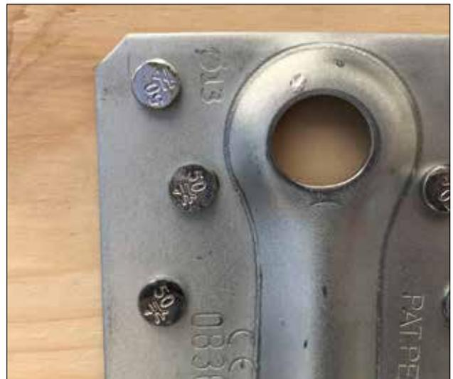
A marcação na conexão, além da marcação na cabeça dos pregos, facilita a verificação após a instalação
