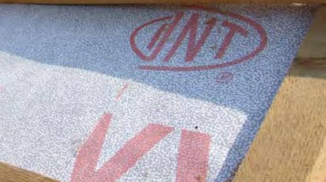
Compare estes números com uma tela de sub-telha multicamadas, cuja camada funcional, mais frágil, pode descer até 10  $\mu\text{m}$ . A espessura da camada funcional de Tyvek® apresenta inúmeras vantagens:
