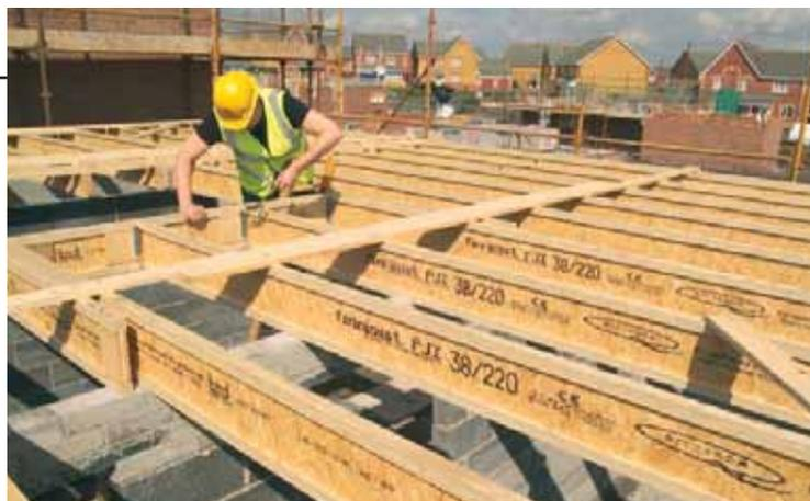
Tipicamente, uma laje destas é simplesmente ancorada na estrutura existente, utilizando um lintel de madeira, ou aplicando ferragens directamente na parede de suporte existente. A nova estrutura adiciona um novo elemento de diafragma ao edifício existente.
